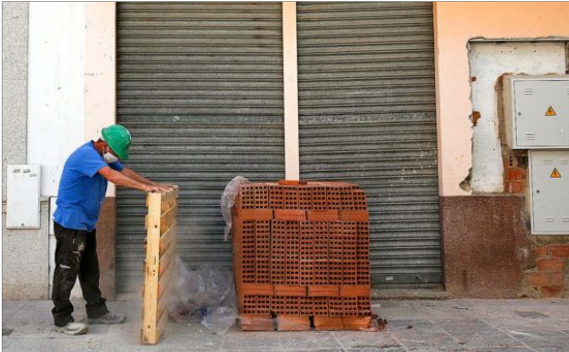
Un empleado del sector de la construcción trabajando en unas obras de reforma en Sevilla. GETTY IMAGES
