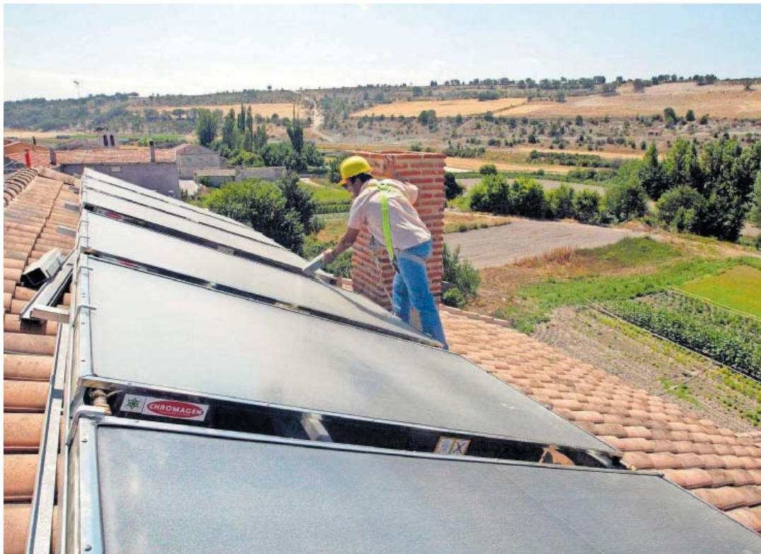
Instalación de paneles solares.
